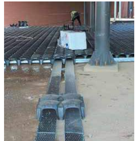
Betonarme Yükseltilmiş Döşeme Reinforced Concrete Raised Floor
