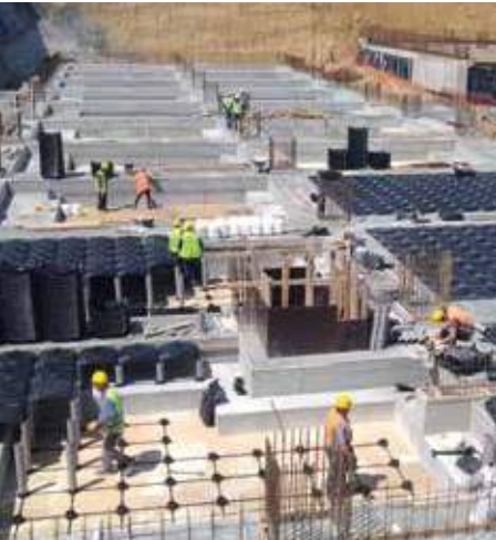
Temel Pabuçları Arasında Dolgu Filling Between Foundation Footings
