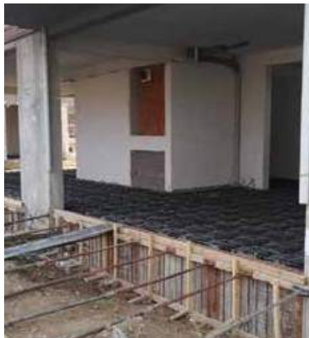
Subasman Yapımı Crawl Space Construction
