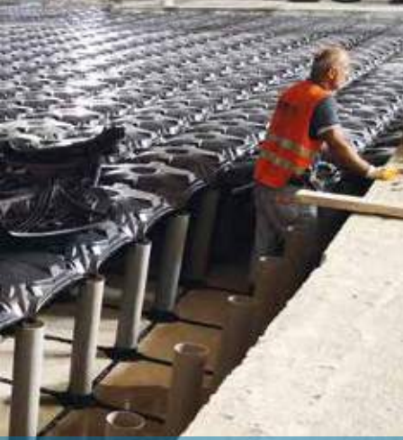
Düşük Döşeme Dolgusu Sunken Slab Filling
