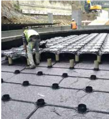
Otopark Rampası Carpark Ramp
